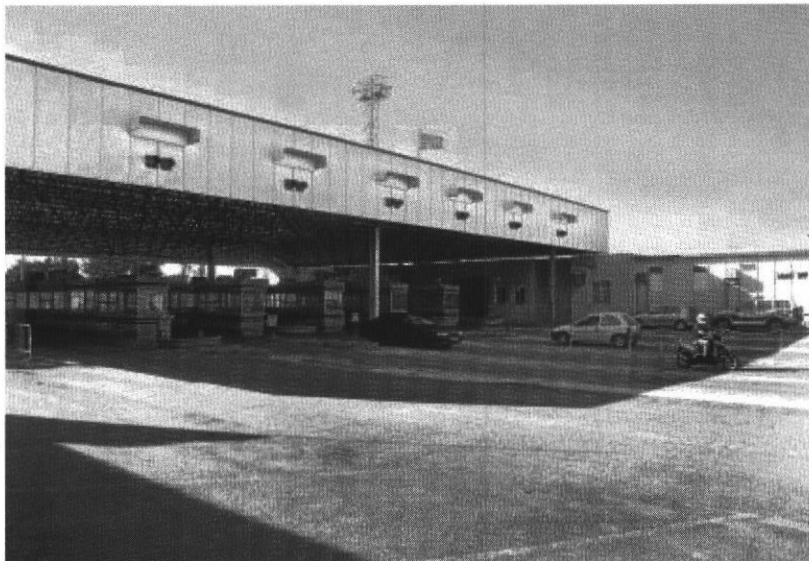
Instalaciones del paso fronterizo en la localidad salmantina de Fuentes de Oñoro./CASAMAR
