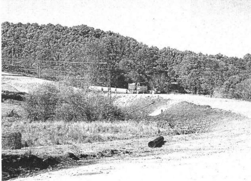
Obras de construcción de un nuevo puente en la carretera Navasfrías-Foios, realizadas en 2008./CASAMAR
